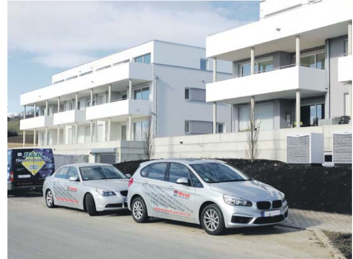
Modern und großzügig: Das Mehrfamilienhaus der Oßwald Wohnbau GmbH im Hilzinger Neubaugebiet »Beim Steppachwiesle«.
