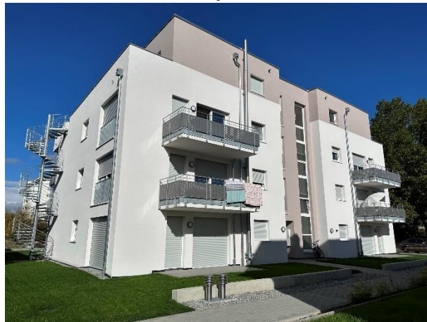
Haus 2 – Blick auf Eingangsbereich
